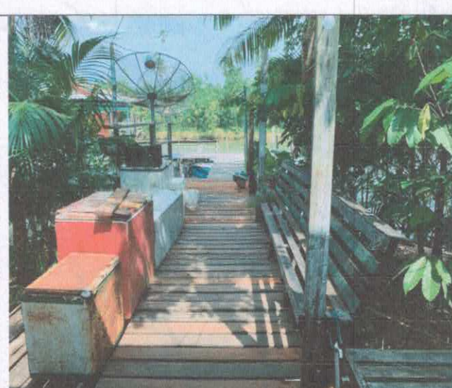
Foto: 01 – Ponte de Acesso.
