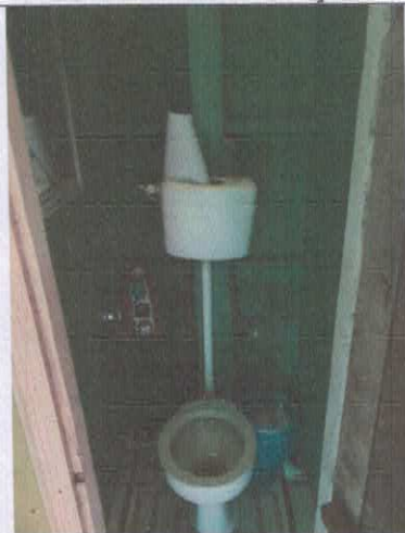
11 – 2.º Pav. Banheiro
