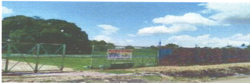
Figura 1 – Portão de Entrada
