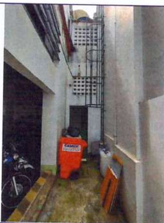
Foto 69: Área de serviços
