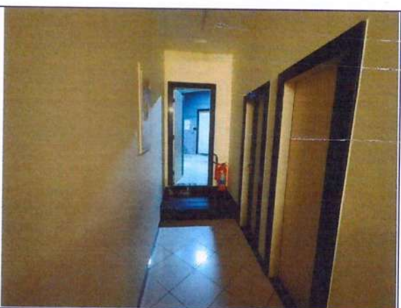
Foto 88: Acesso a sala de som
