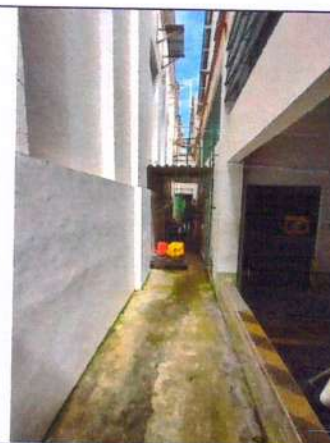
Foto 70: Área de serviços
