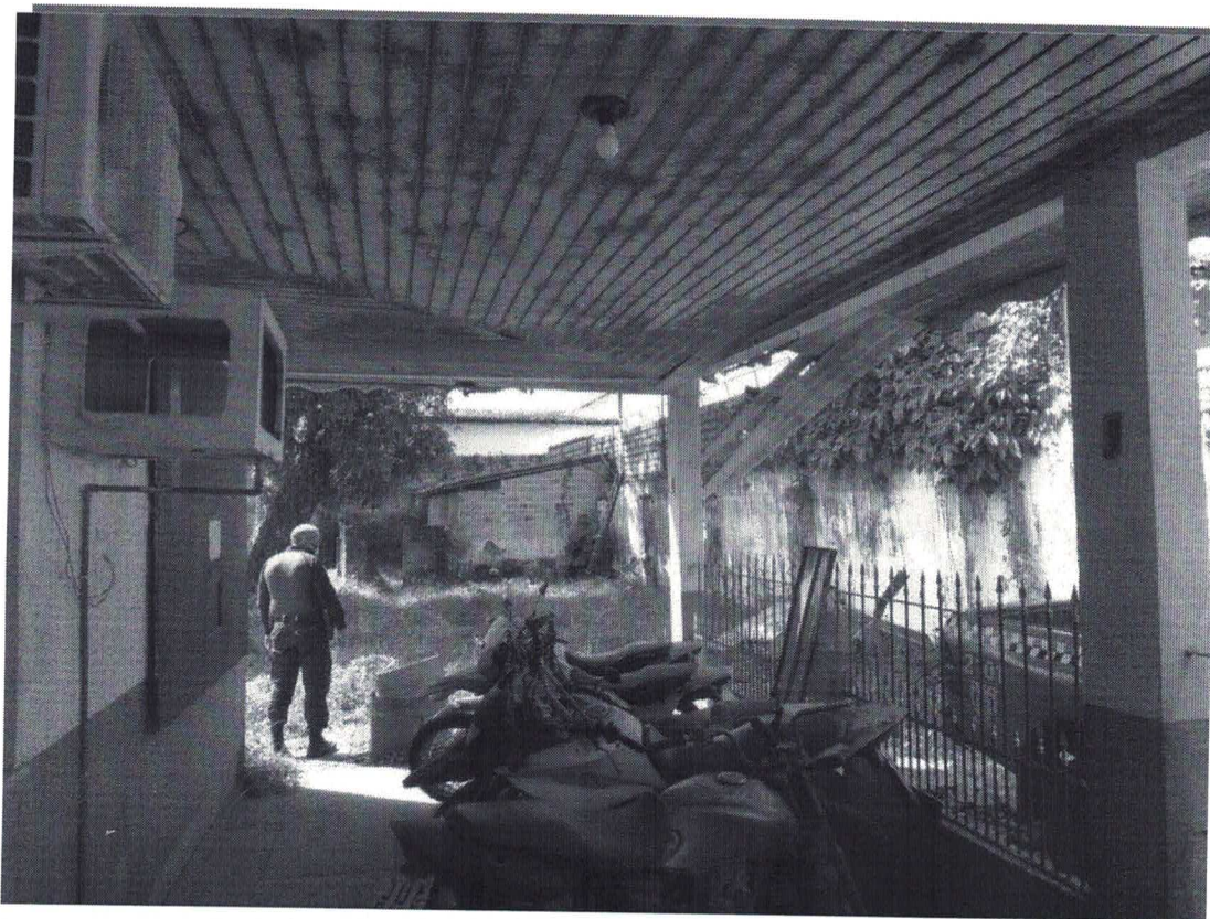
LATERAL DO HALL DE ENTRADA
