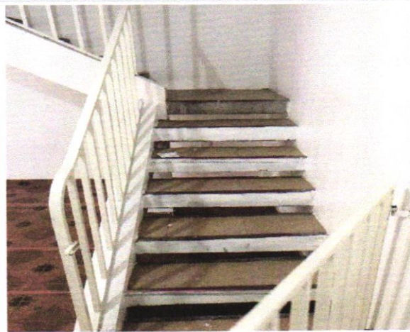
Foto 20 – Escada (acesso Pav. Superior)
