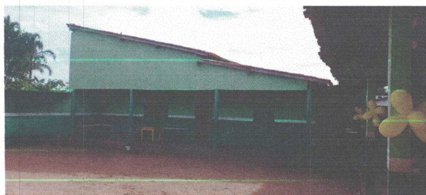
Circulação – Frente das Salas de aula (Bloco 02).
