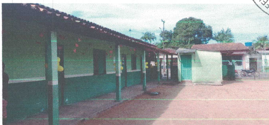
Circulação – Frente das Salas de aula (Bloco 01).
