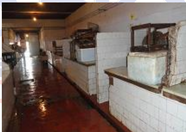
FOTO 07 – ASPECTO GERAL DA CANALETA EXISTENTE
