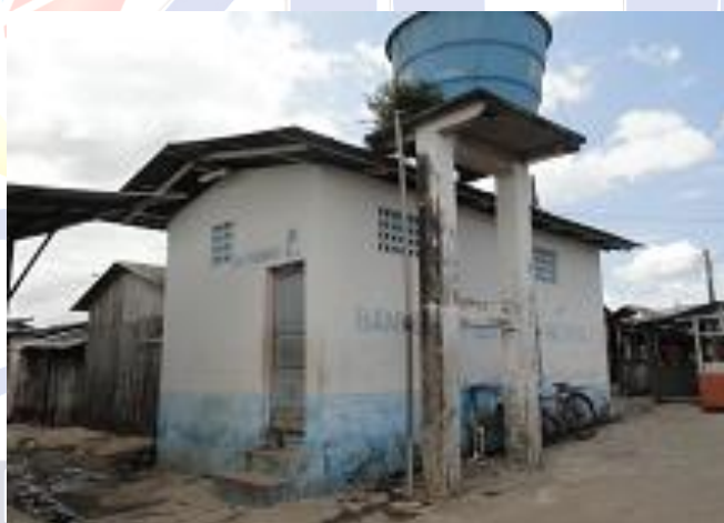
FOTO 08 – PRÉDIO E ESTRUTURA DE APOIO – A DEMOLIR
