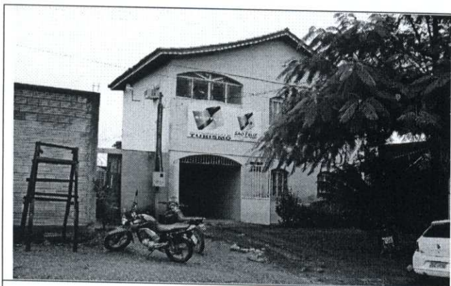
Imagem 01: Fachada Frontal da edificação (fora do padrão);
