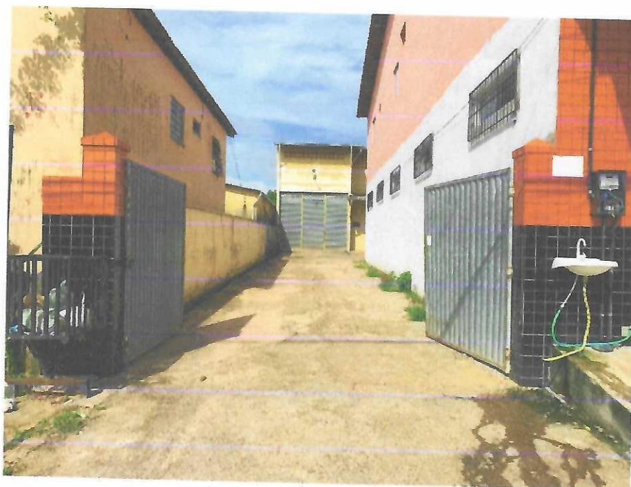
Vista Frontal Entrada da Edificação
