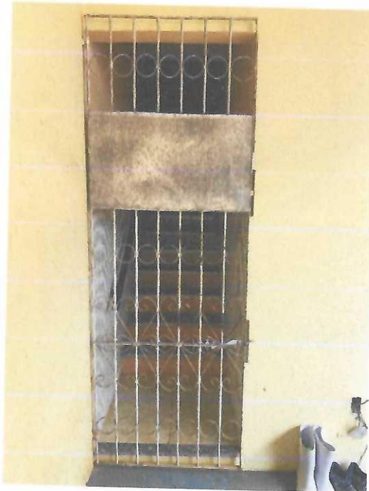
Vista de Acesso ao Pavimento Superior
