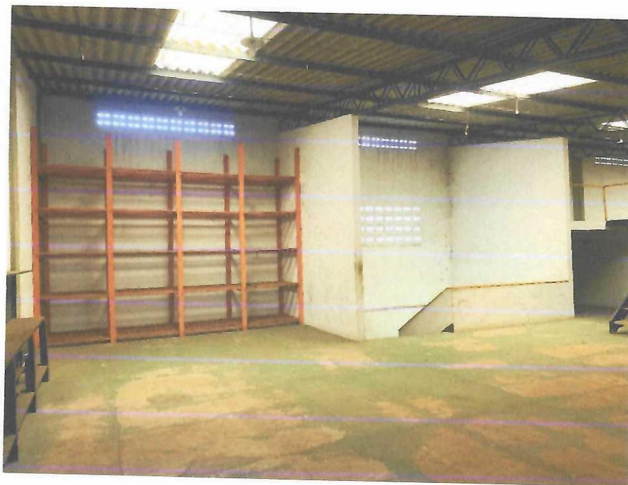
Vista interna Sala 03
