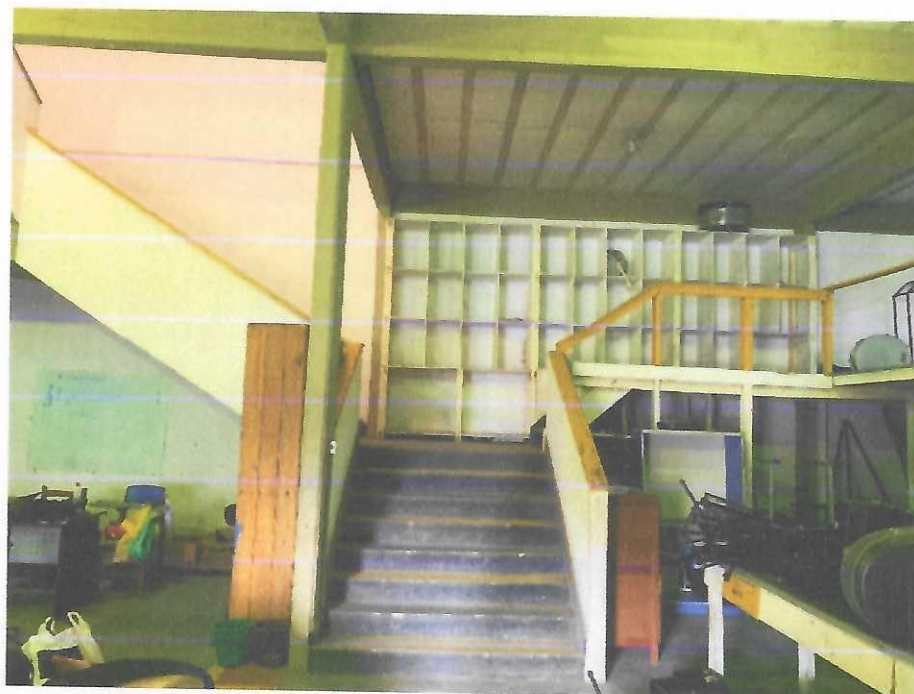
Vista interna Escada de Acesso Sala 02
