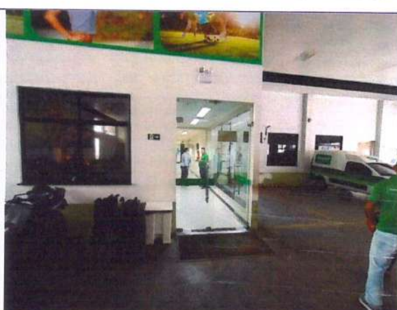
Foto 60: Saída para garagem/estacionamento
