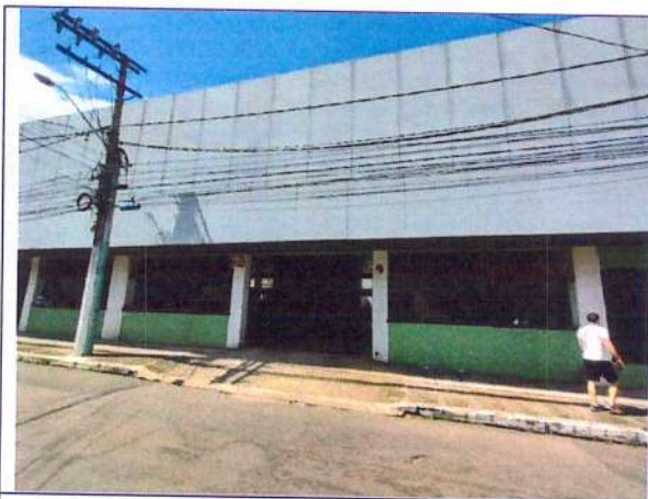
Foto 05: Entrada e saída do estacionamento/garagem
