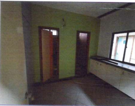
Foto 50: Acesso aos banheiros
