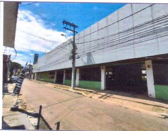
Foto 06: Entrada e saída do estacionamento/garagem
