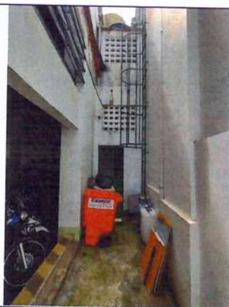
Foto 69: Área de serviços
