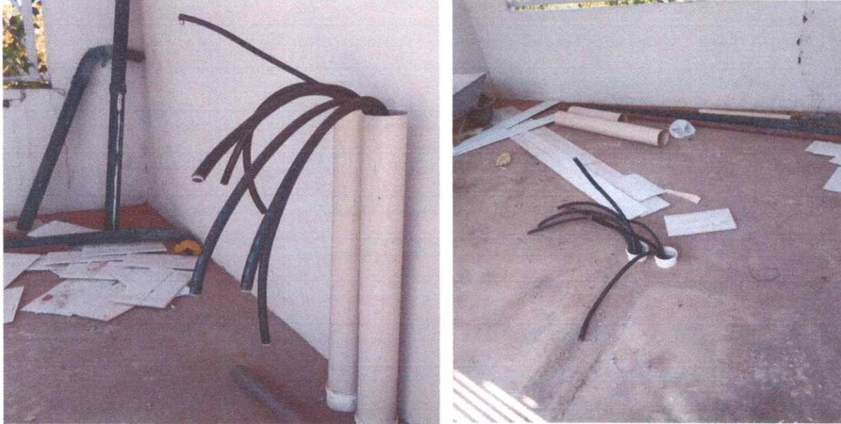
Figura 02 \_ Cabeamento de espera dentro do abrigo destinado ao Grupo Gerador.
