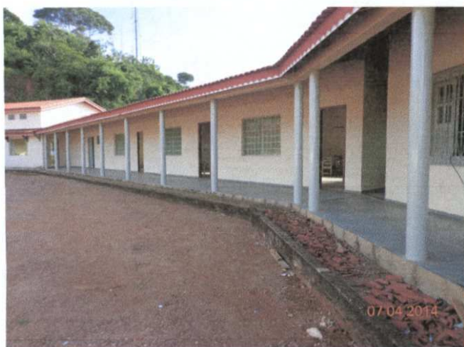
Imagem 03: Vista externa da edificação Anexo III;
