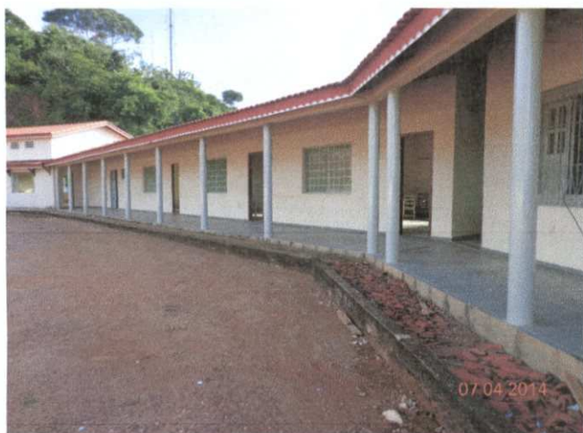
Imagem 03: Vista externa da edificação Anexo III;
