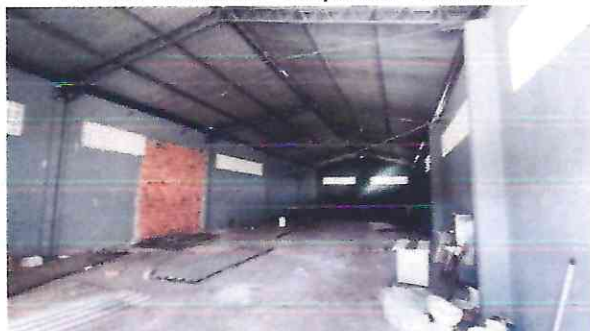
Foto 05: Vista interna do galpão
