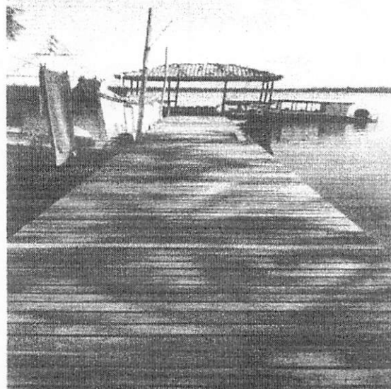
Foto 02 – ponte de acesso
