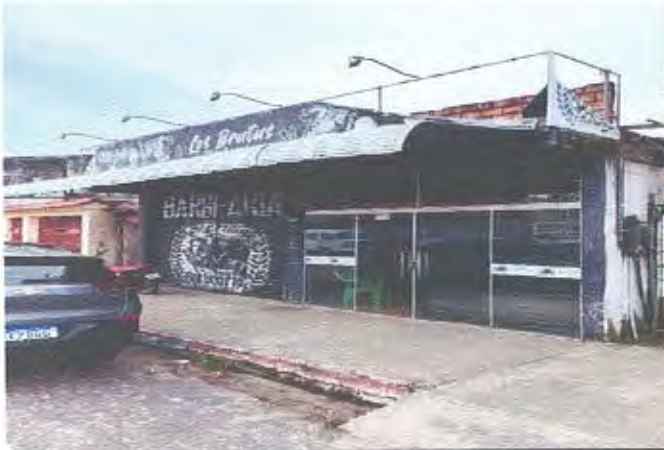
Acesso ao imóvel pela travessa
