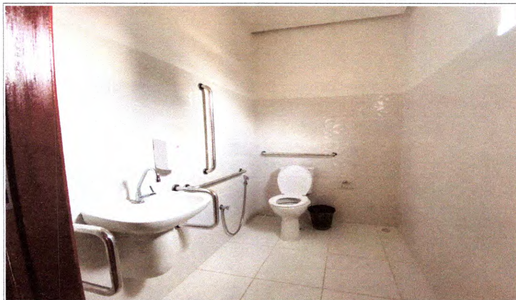
Foto 20: Banheiro PcD atendendo às normas de acessibilidade.
