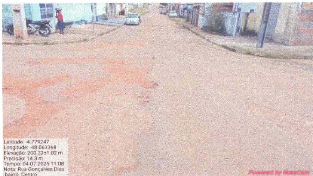
Figura 2 - via de acesso entre bairros
