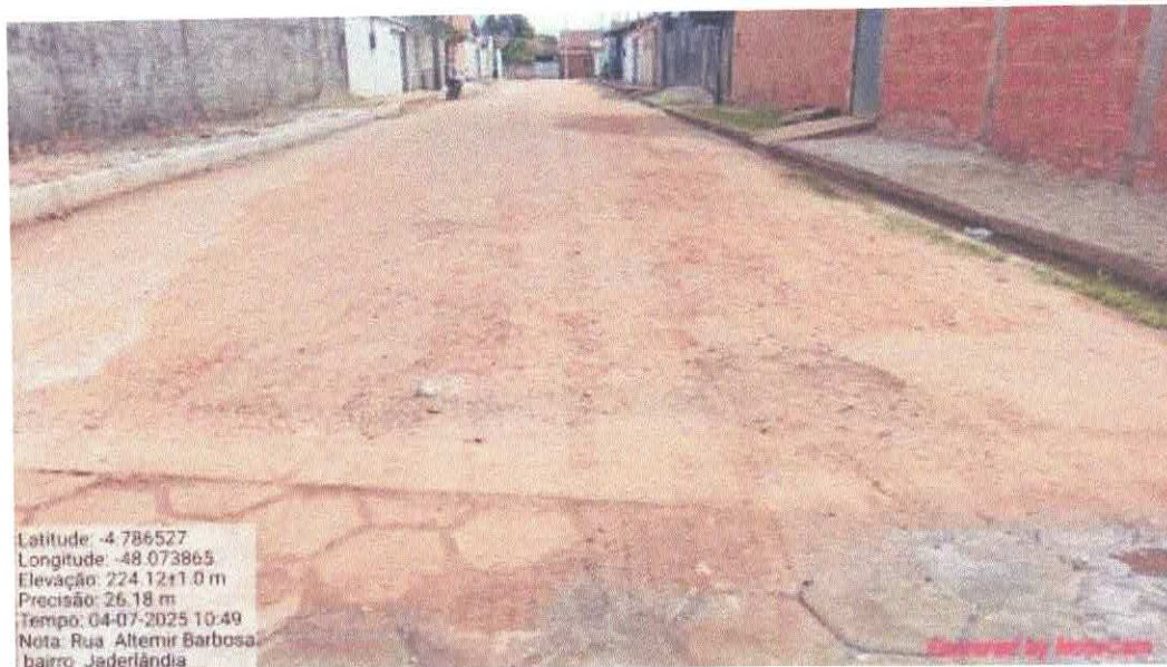
Figura 7 - Recuperação via de acesso residencial
