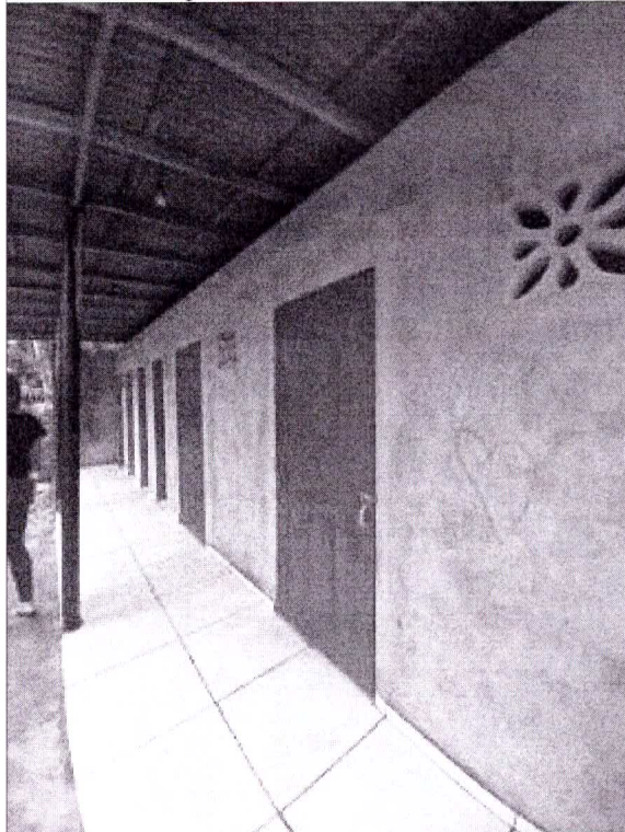
Figura 02 – Anexo de Banheiros
