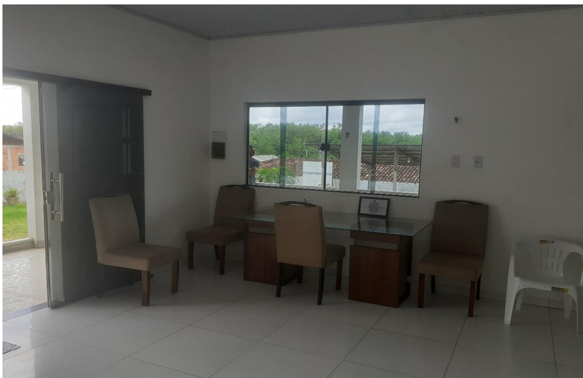
FOTO 08: ESQUADRIAS DE VIDRO.
