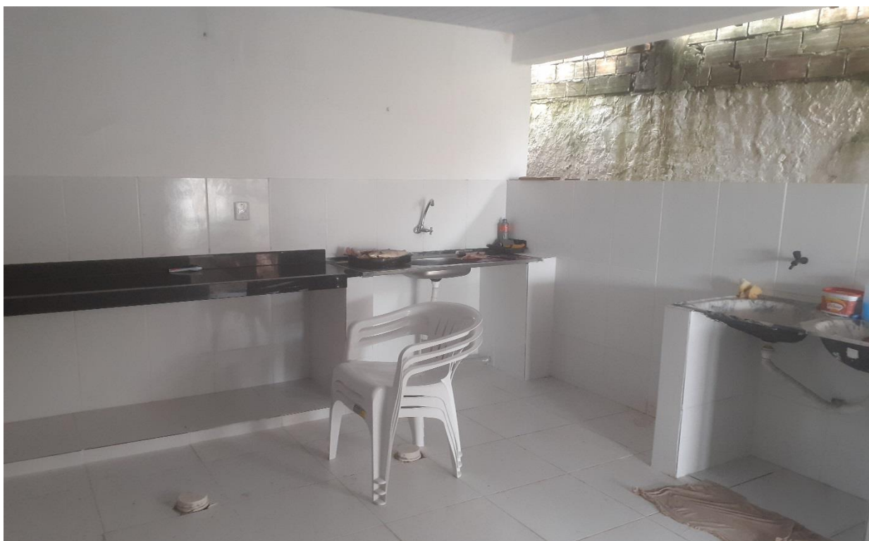
FOTO 04: REVESTIMENTO CERÂMICO DE PAREDE
