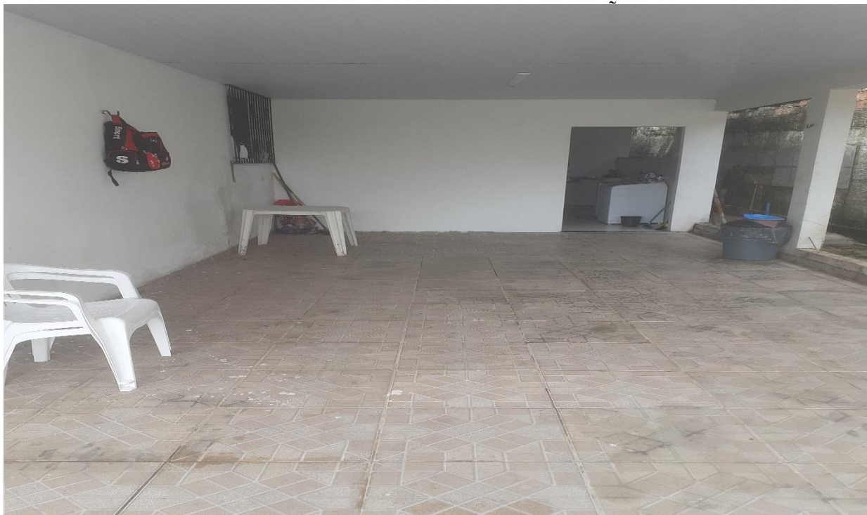
FOTO 03: REVESTIMENTO CERÂMICO DE PISO – GARAGEM.
