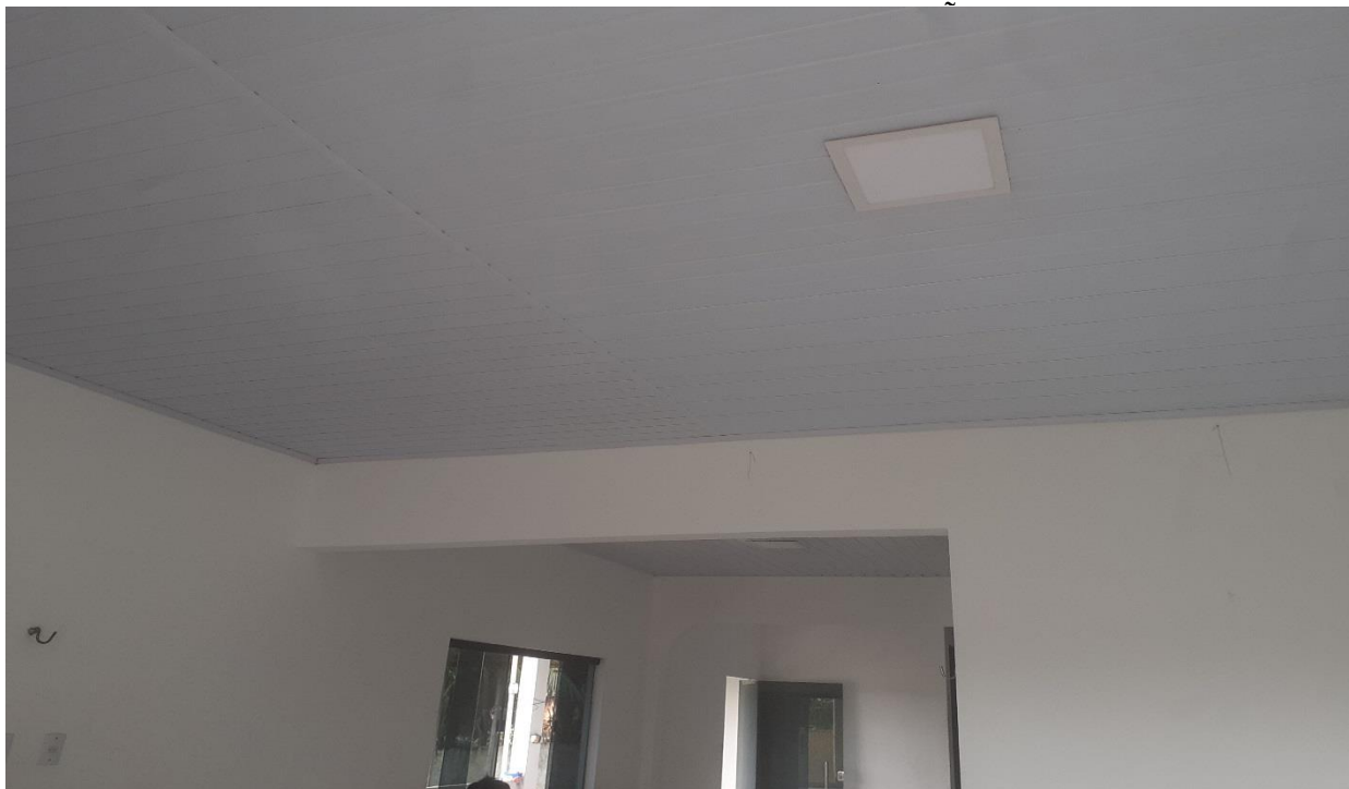
FOTO 05: FORRO EM LÂMINA PVC.
