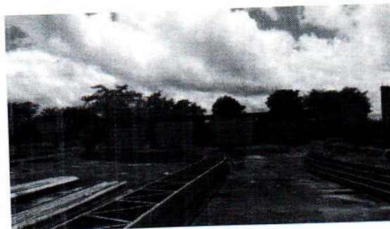
Foto 16 e 17 – Arcos metálicos armazenados de forma irregular
