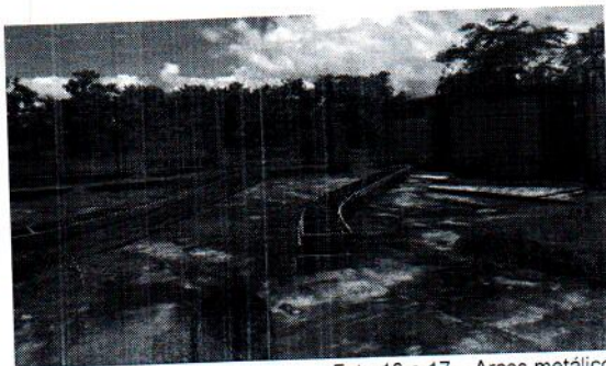
Foto 16 e 17 – Arcos metálicos armazenados de forma irregular
