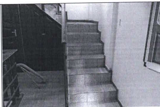
FOTO 20: ESCADA 2º PISO SOBE
