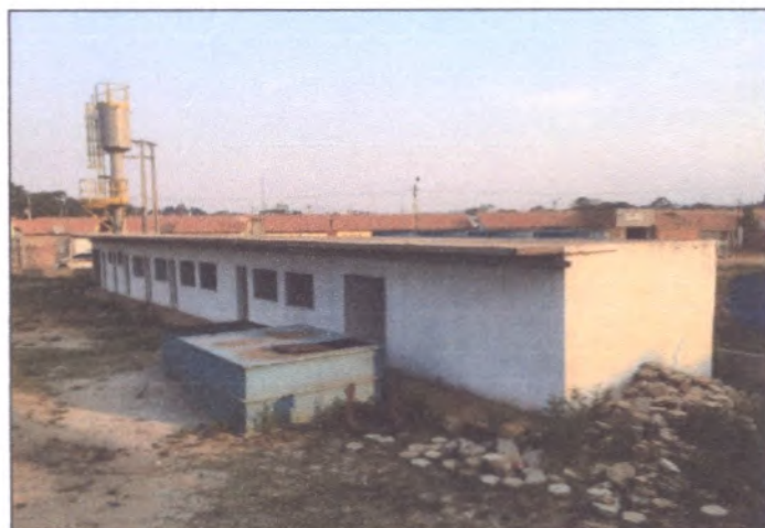
Foto 04 - Casa de química, laboratório e escritório
