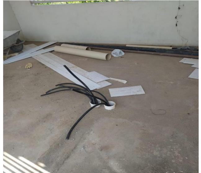
**Figura 02 \_ Cabeamento de espera dentro do abrigo destinado ao Grupo Gerador.**
