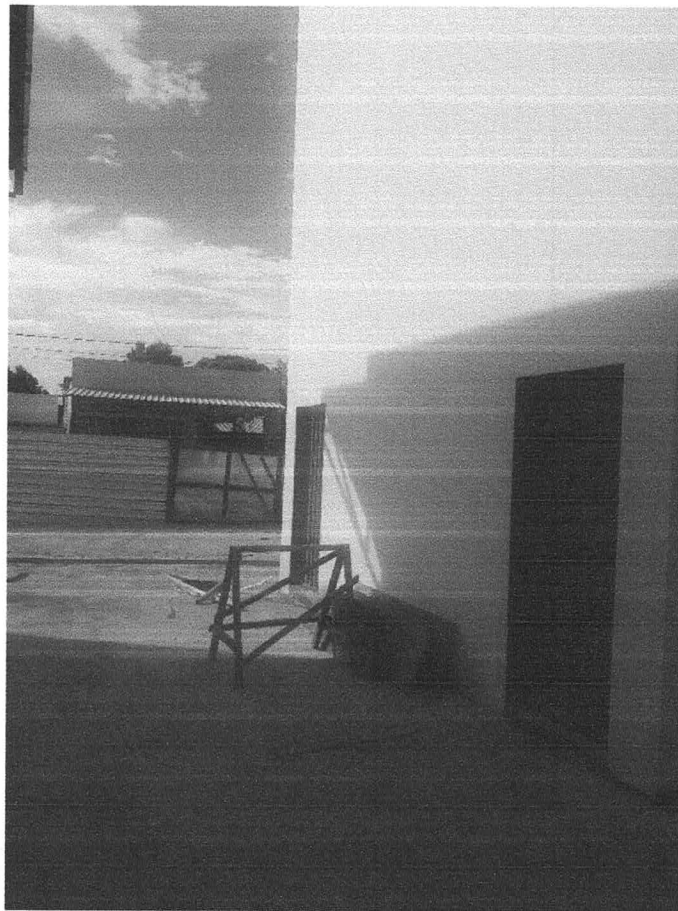
Edificação do local do reservatório
