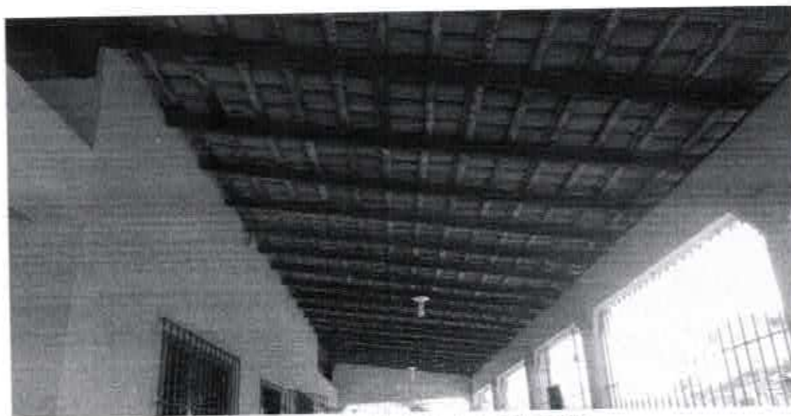
Foto 04 – Vista do telhado da circulação/varanda
