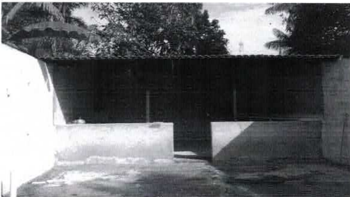
Foto 14 – Vista da edícula da Edificação
