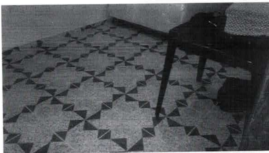
Foto 08 – Vista do piso do quarto da Edificação
