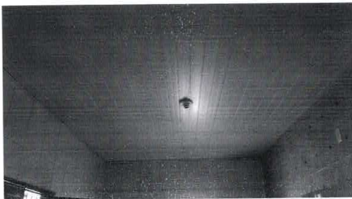
Foto 10 — Vista do forro do banheiro da Edificação
