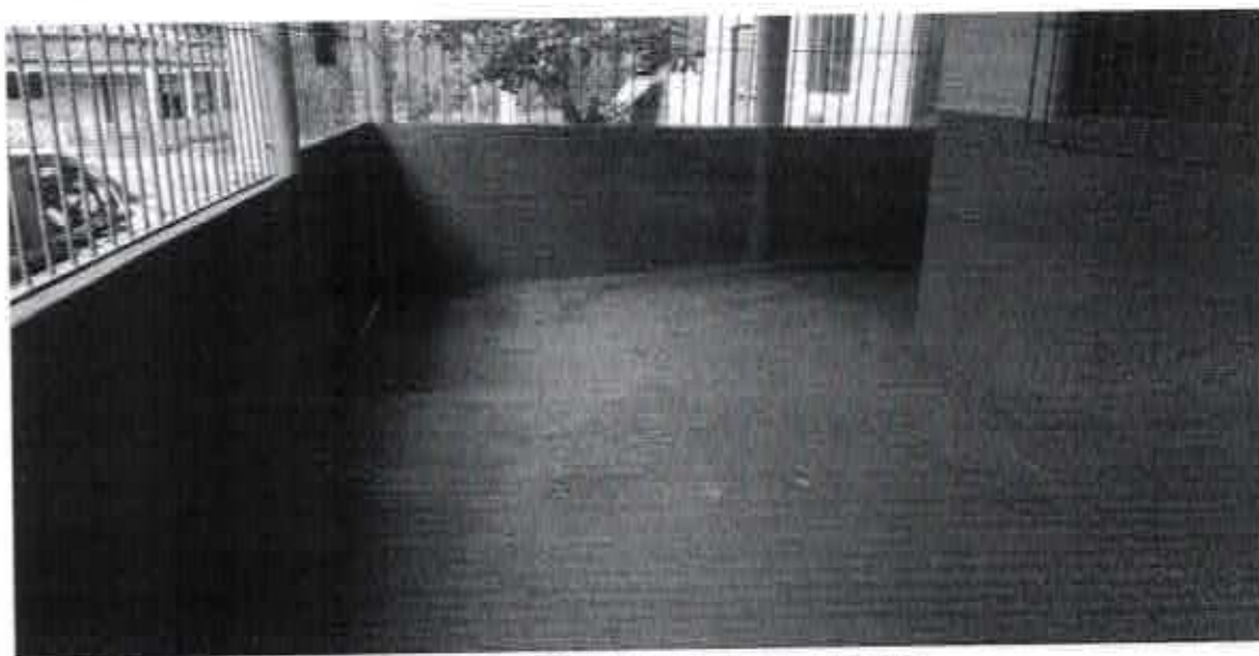
Foto 02 - - Vista do piso da Varanda
