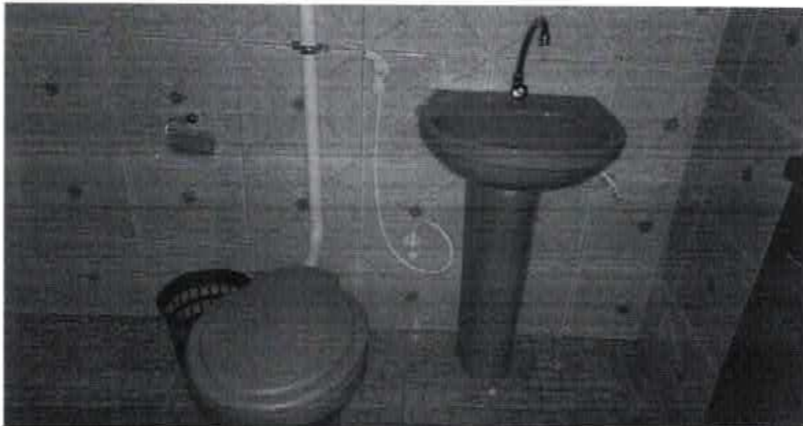
Foto 13 - Vista da parede e louça do banheiro
