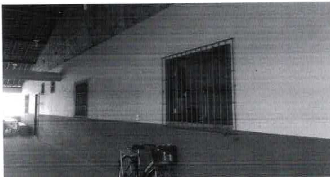
Foto 09- Vista da parede lateral da Edificação
