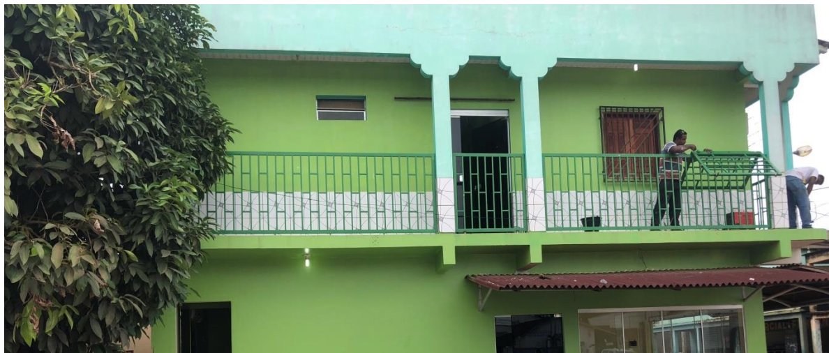
Vista Frontal da fachada da edificação.
