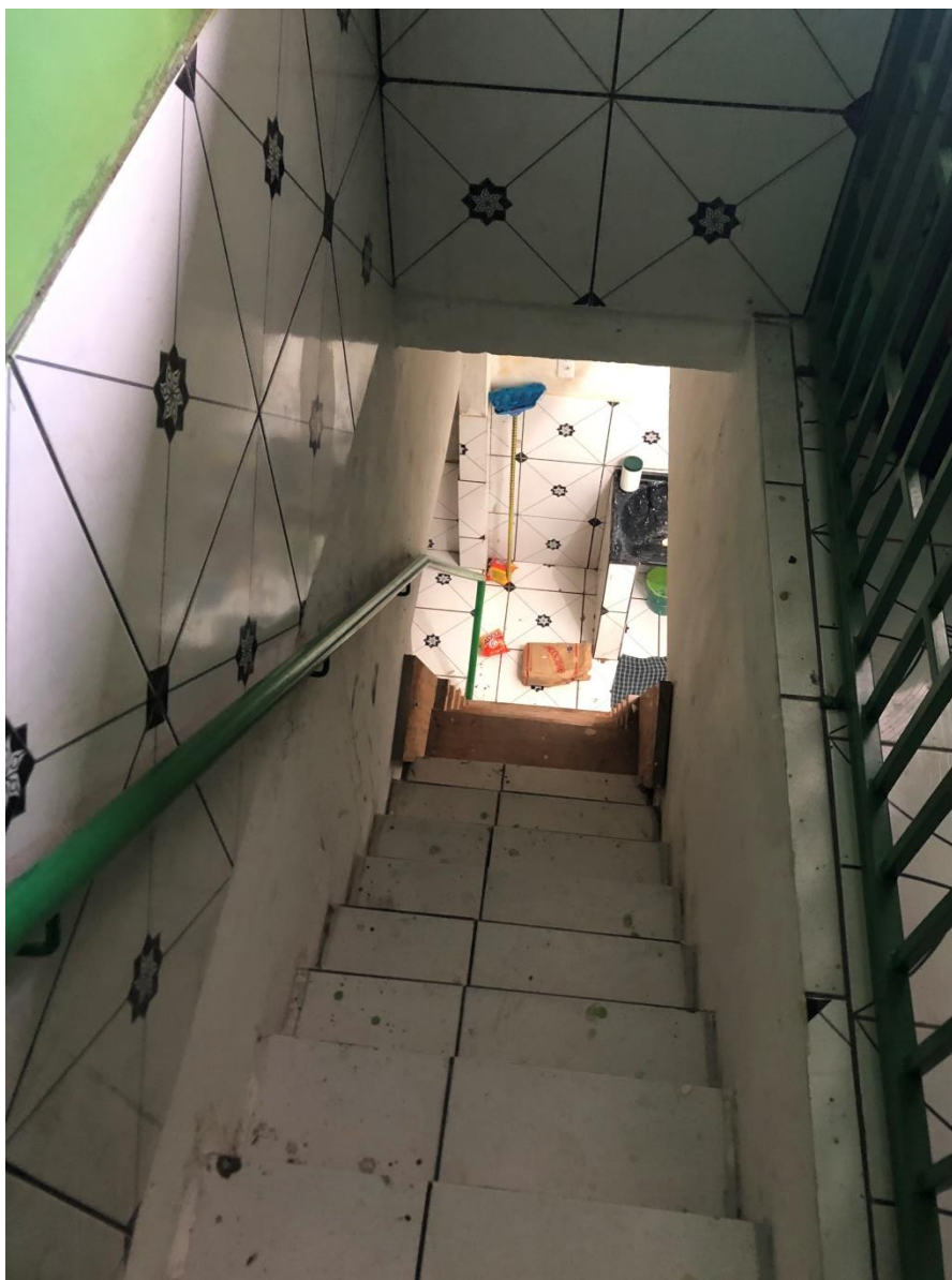
Escada que dá acesso à lavanderia.
