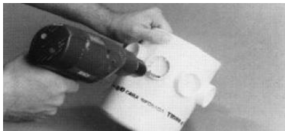
Abertura dos furos nas caixas sifonadas.
