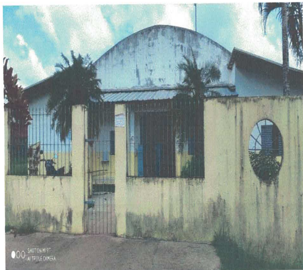
Figura 01 – Entrada do prédio
