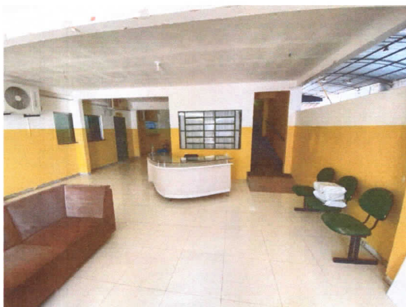
Figura 2 – Sala de entrada da edificação - recepção
