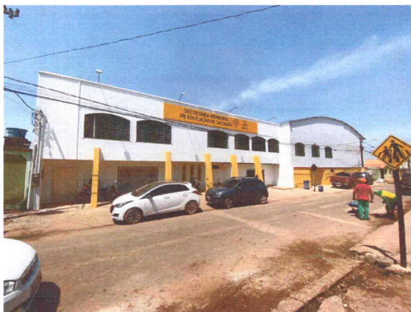
Figura 1 – Vista frontal da edificação
