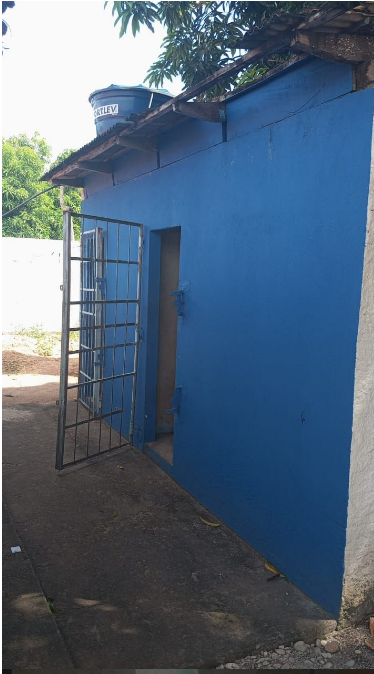
IMAGEM 5 : SALA DE DETENÇÃO PROVISÓRIA
