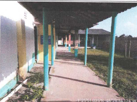
FOTO 11 – CORREDOR DE ACESSO AO PRÉDIO
