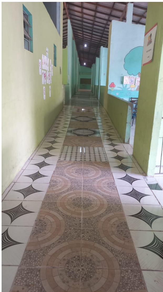
Figura 2 - Vista da circulação técnica do imóvel
