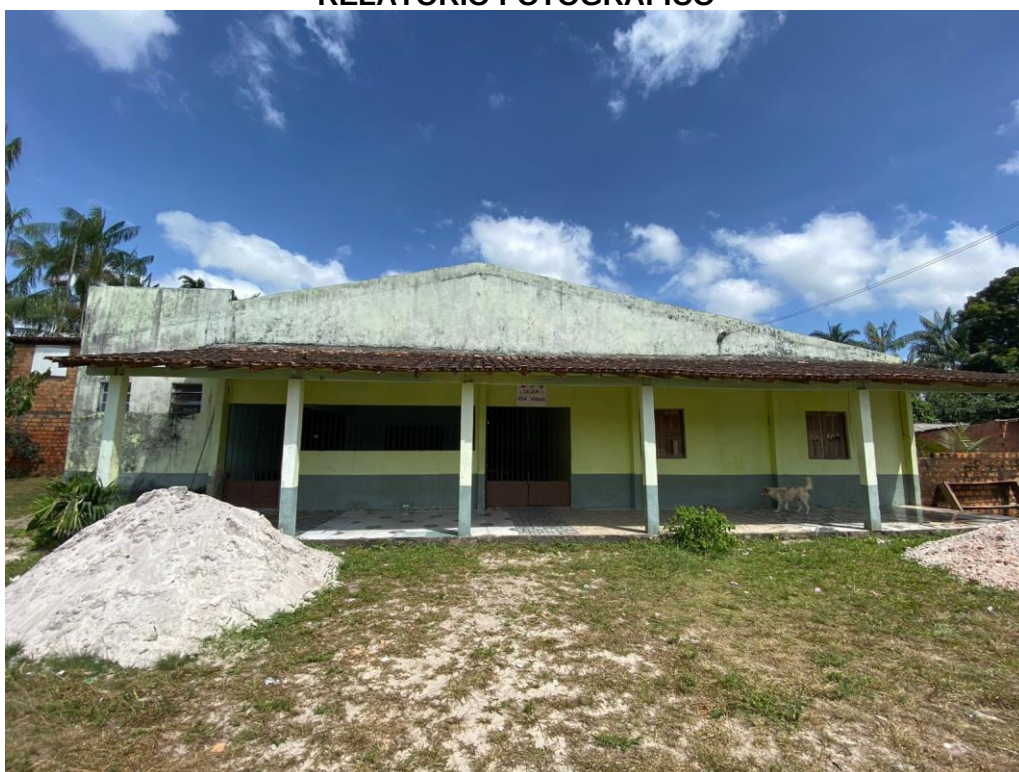
Figura 1 - Vista frontal da edificação
