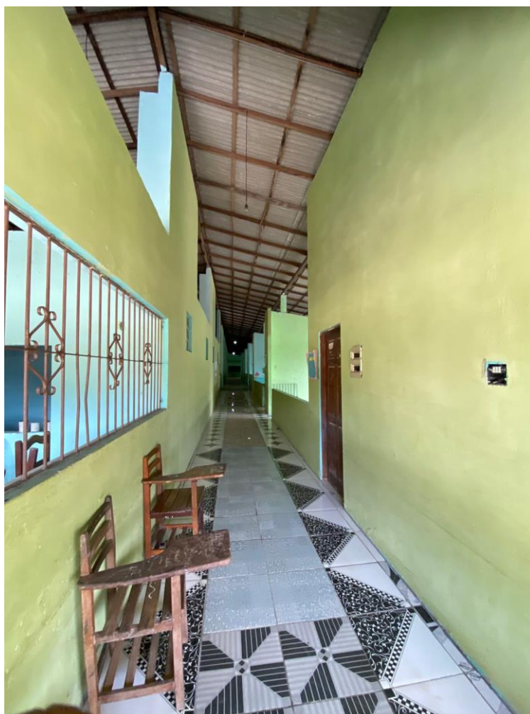
Figura 4 – Vista da circulação técnica
