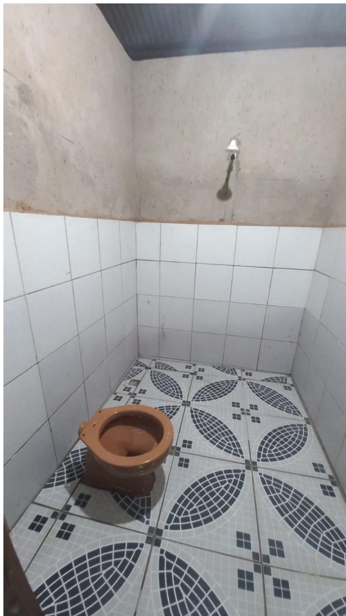
Figura 6 - Vista do banheiro do imóvel
