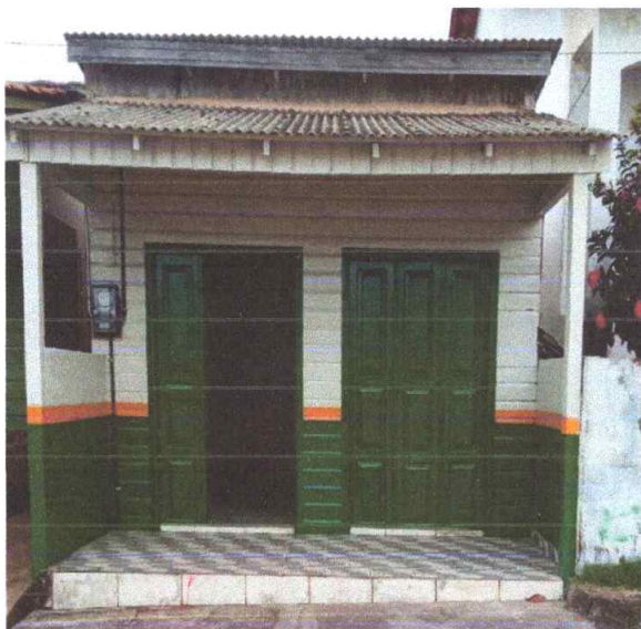
IMAGEM 01 VISTA PARCIAL DO IMÓVEL
