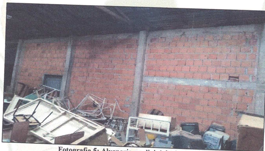
Fotografia 5: Alvenaria na divisória do galpão.
