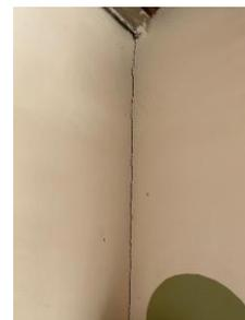
**IMAGEM 08: BANHEIRO EXTERNO; RACHADURA EXISTENTE ENTRE AS PAREDES.**
