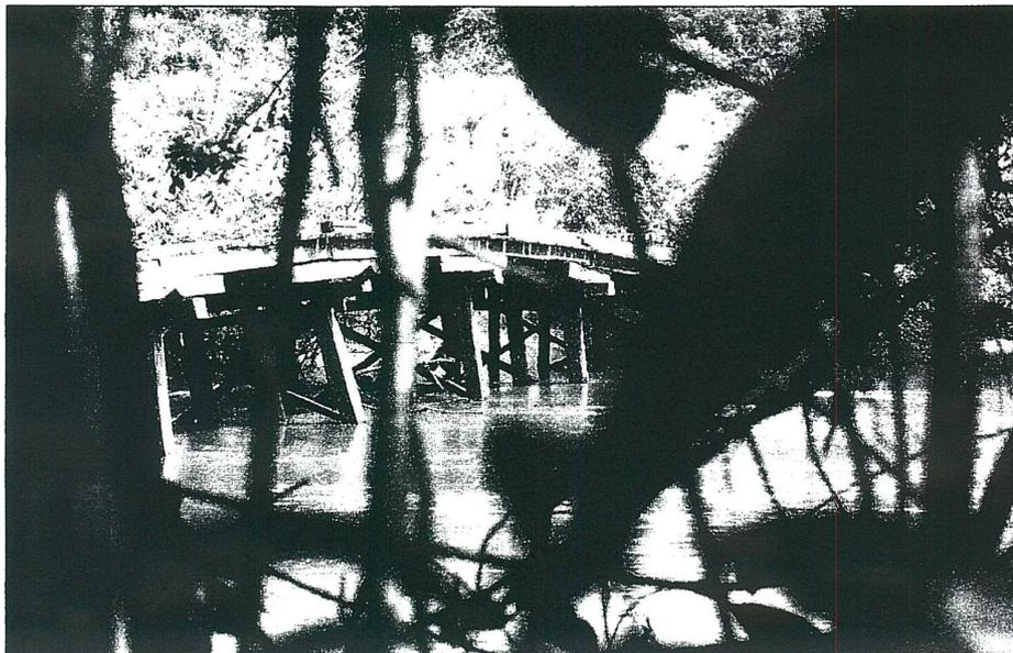
**LEGENDA:** Estrutura de pilares da ponte tortos pela força da enxurrada. Estrada Vicinal Corredor do Boi, próximo à Vila Unida do Norte. Data: 19/04/2017, Destruição de uma ponte sobre o Rio Pacajá por uma enxurrada. (Coordenadas UTM: 529000 E, 9468081 N, DATUM SIRGAS 2000, zona 22 S).
