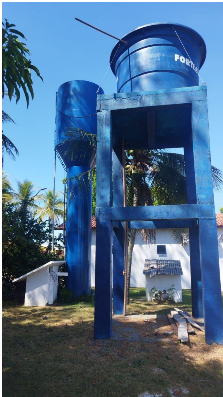
IMAGEM 10: RESERVATÓRIO DE ABASTECIMENTO
