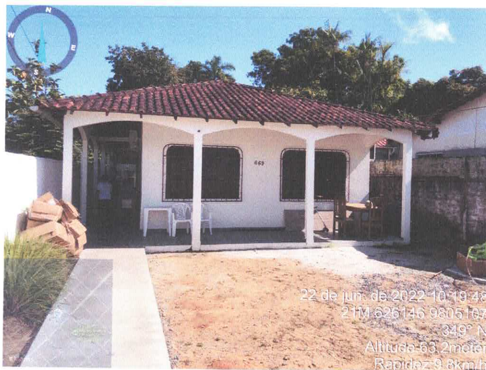
Figura 7 – Condições estruturais e cobertura.
