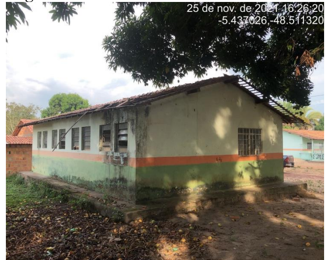
Figura 108. UBS Vila Ponta de Pedra do Araguaia
