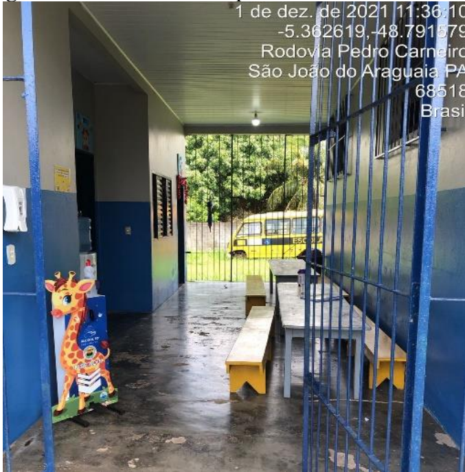
Figura 15. Creche Municipal Merivaldo Paiva
