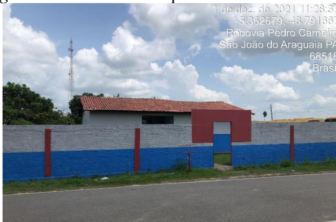
Figura 13. Creche Municipal Merivaldo Paiva
