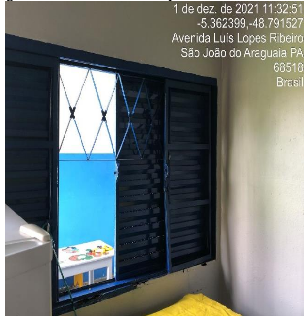
Figura 16. Creche Municipal Merivaldo Paiva
