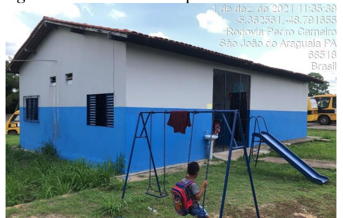
Figura 14. Creche Municipal Merivaldo Paiva
