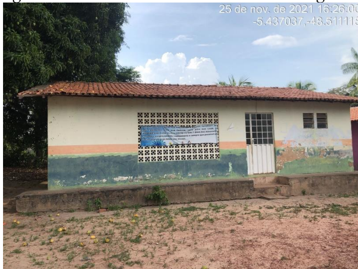
Figura 107. UBS Vila Ponta de Pedra do Araguaia
