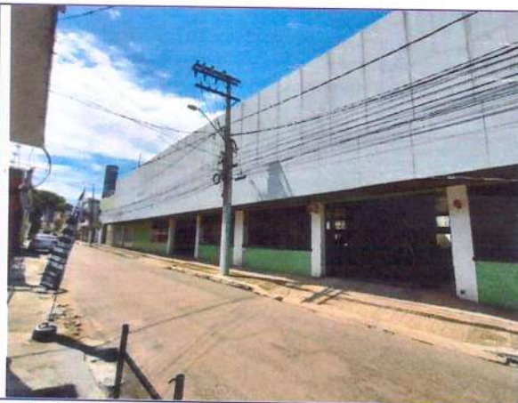
Foto 06: Entrada e saída do estacionamento/garagem
