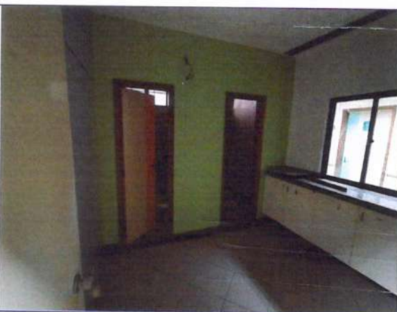
Foto 50: Acesso aos banheiros
