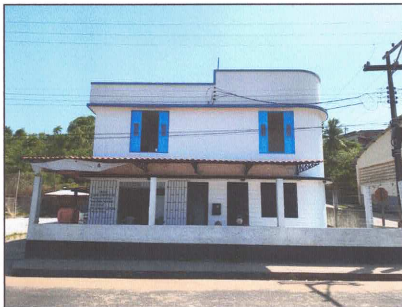
Figura 1 – infraestrutura, estrutura e cobertura
