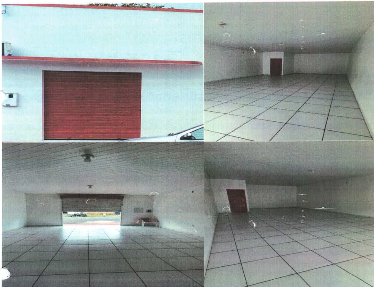
Figuras 8,9,10,11 – Sala Anexa com Banheiro
