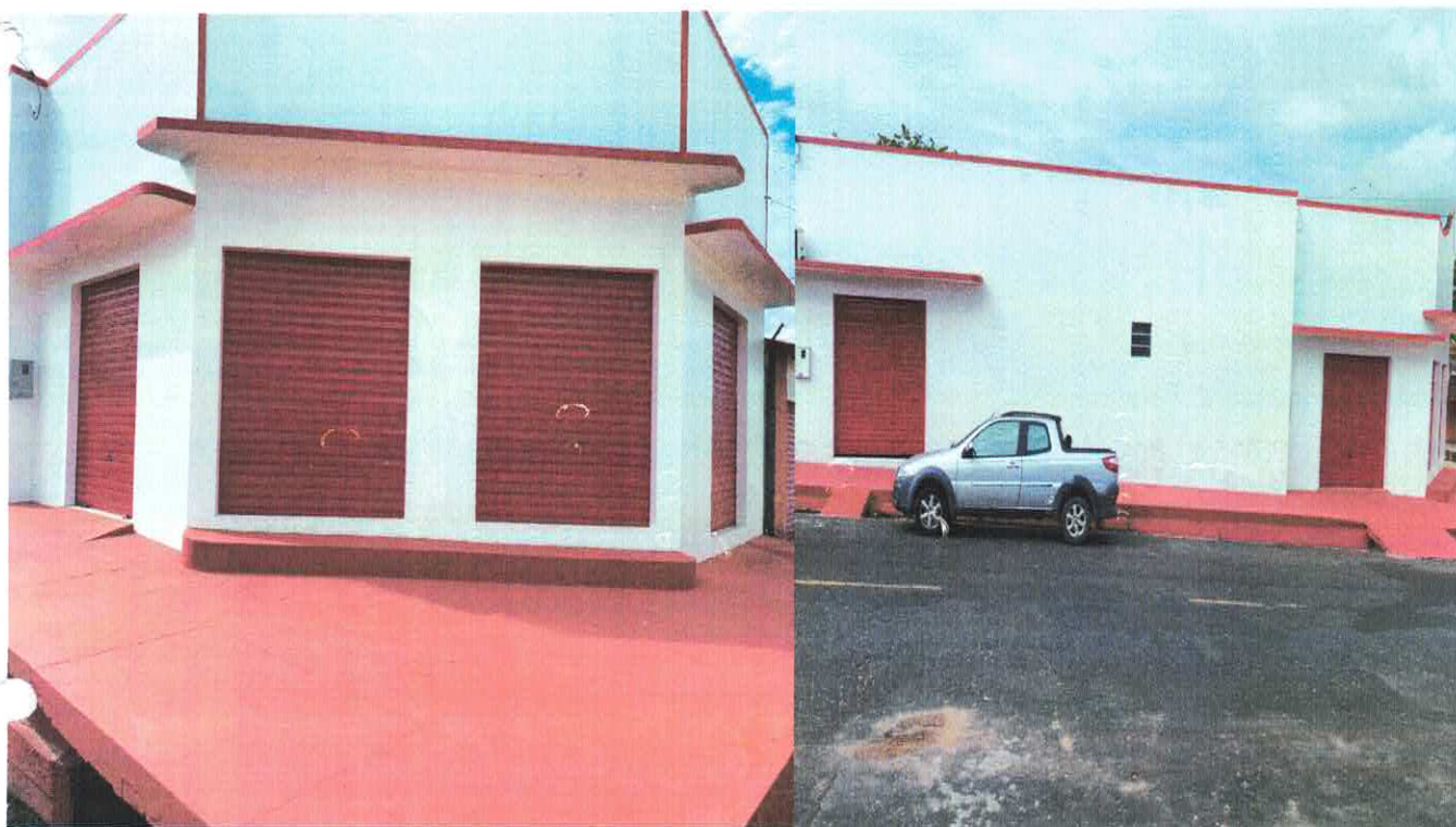
Figuras 1 e 2 – Fachada da Edificação
