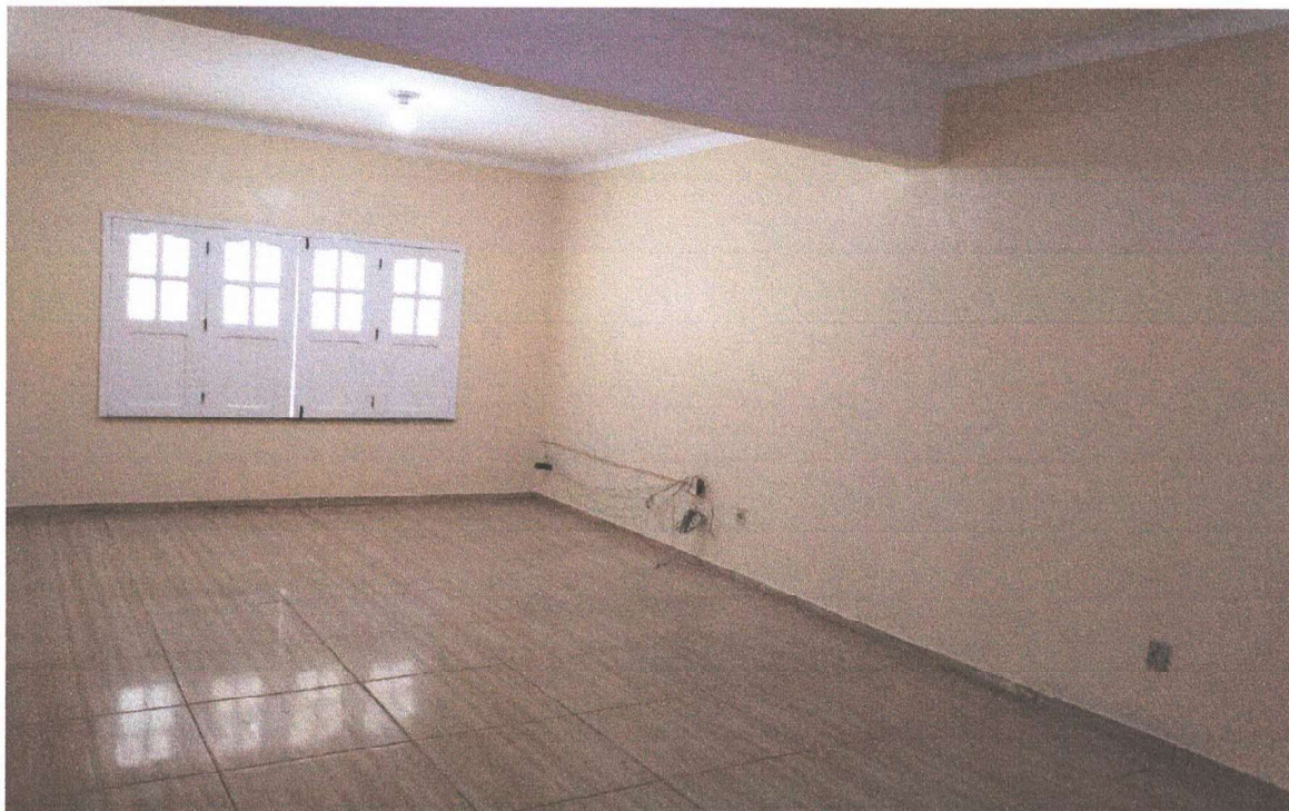
Figura 05; sala de estar piso cerâmico e forro em pvc, porta em madeira e vidro.
