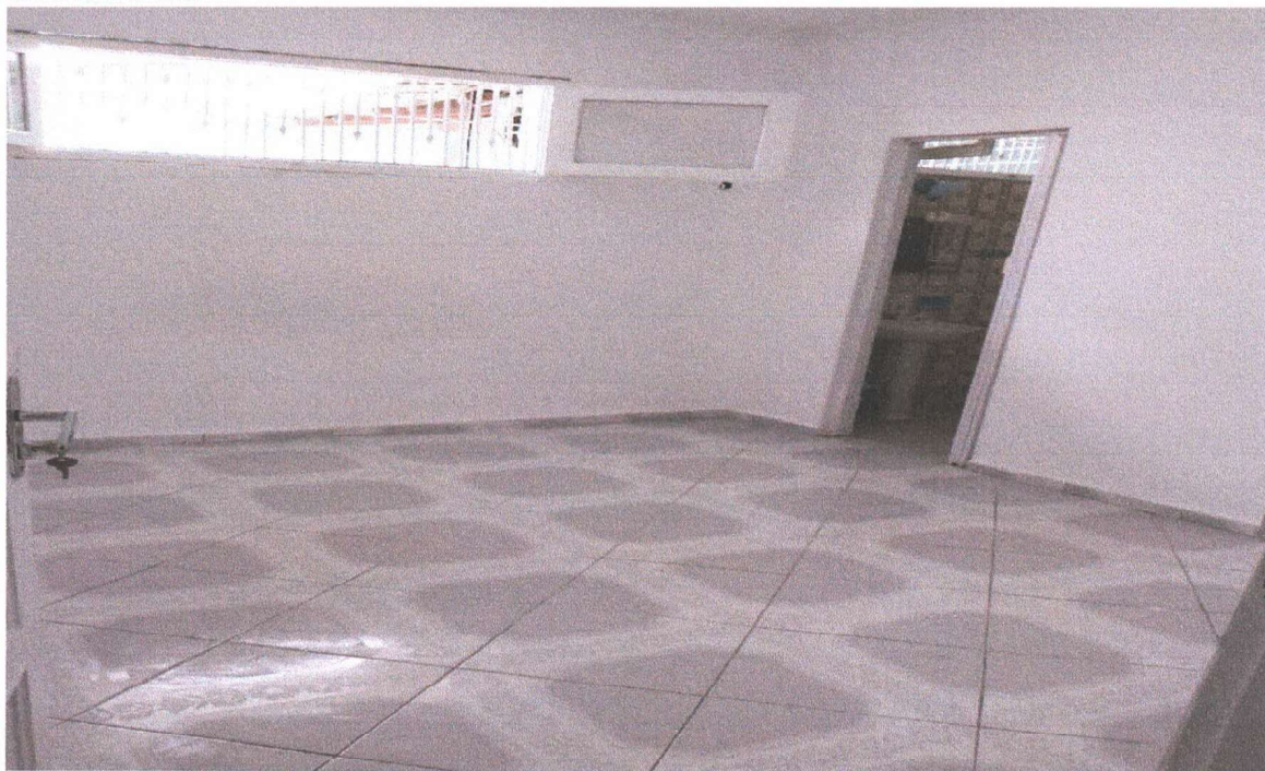
Figura 09; suíte com janela de alumínio e vidro, piso cerâmico.
