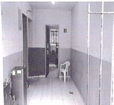
FOTO 07 ACESSO ÀS SALAS DE AULA
