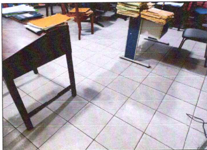
Foto 02: Piso cerâmico (Padrão médio). Fonte: SEPLANO
