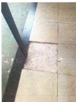
IMAGEM 03: AUSENCIA DE REVESTIMENTO CERAMICO NO SALÃO DO PAV. TÉRREO.
