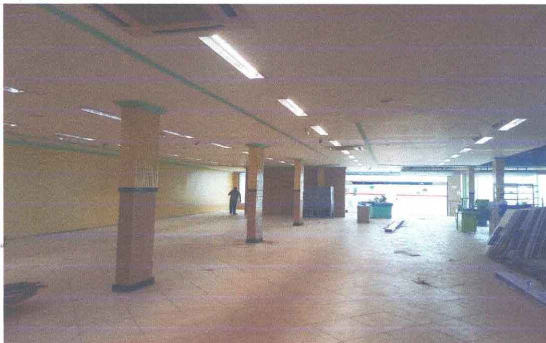
Vista interna - Salão do Pavimento térreo do imóvel avaliando
