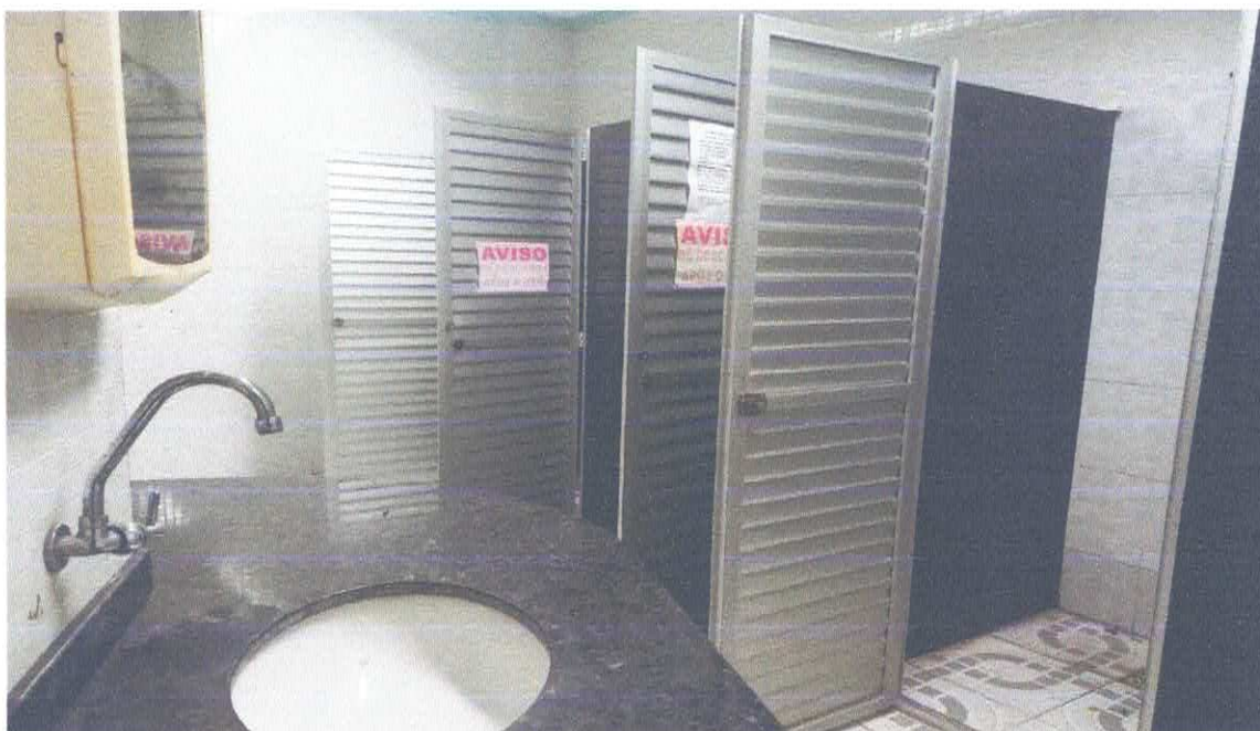
Vista interna – Vestiário/Banheiro do Segundo Pavimento do imóvel avaliando
