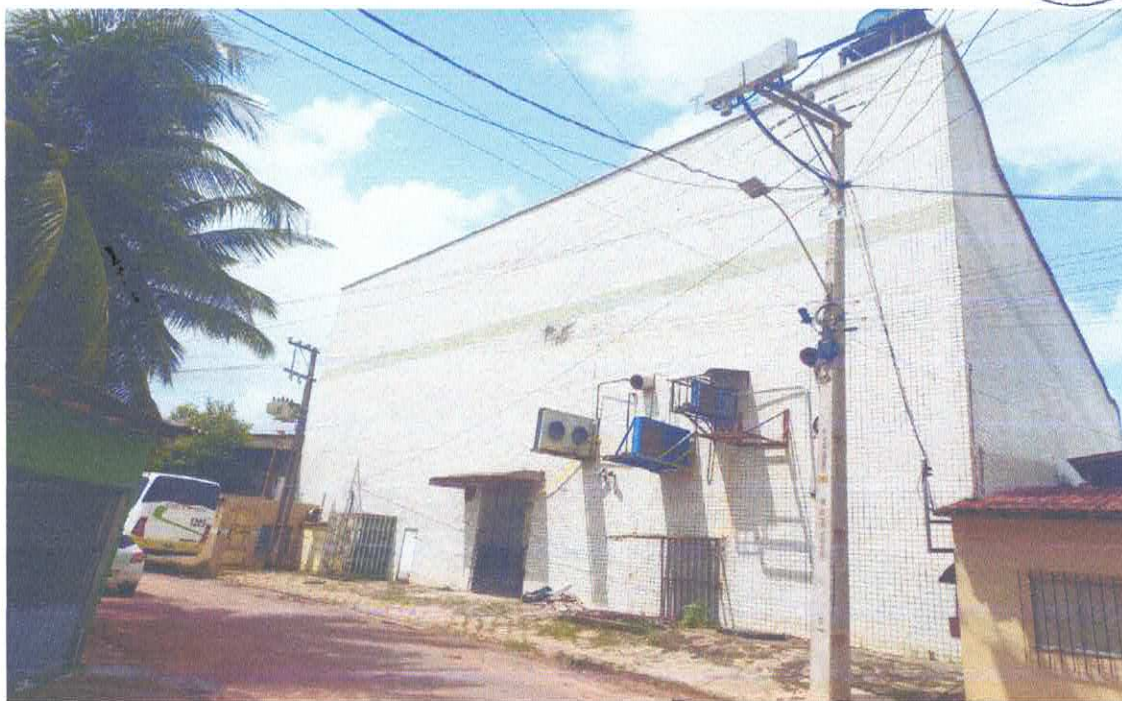
Vista dos fundos do imóvel avaliando
