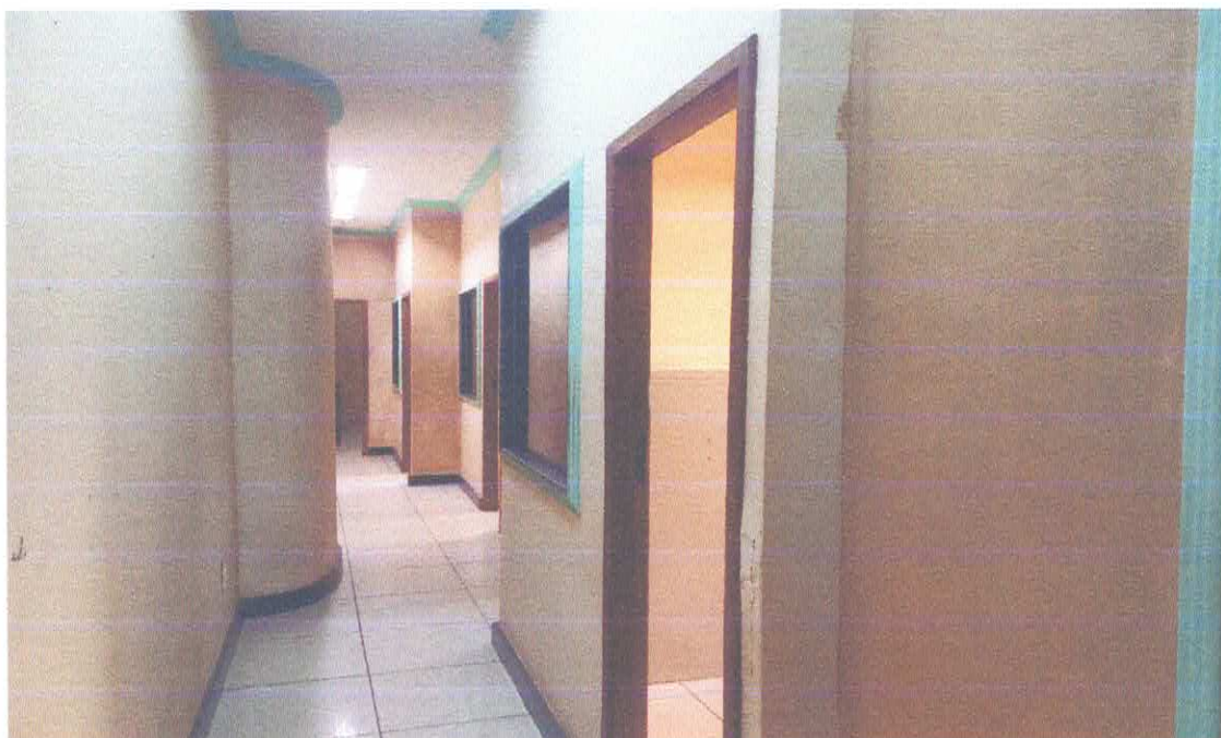
Vista interna – Hall de entrada das salas do Segundo Pavimento do imóvel avaliando
