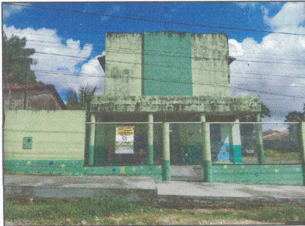
FOTO 01- Acesso à Igreja.
