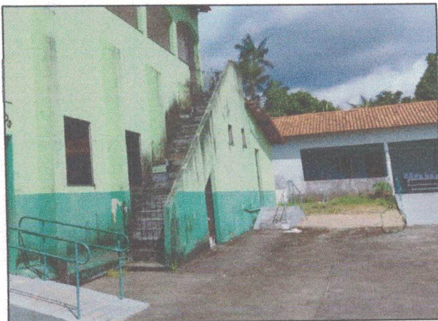
FOTO 03- Escada que dá acesso a parte superior.
