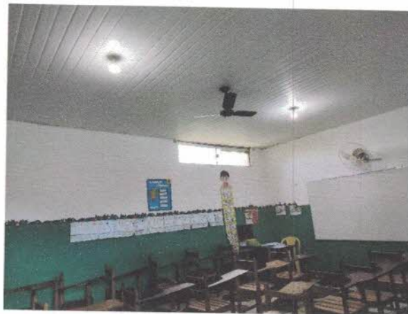
Figura 8 - Forro Novo - Sala de Aula
