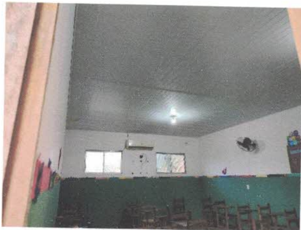
Figura 7 - Forro Novo - Sala de Aula
