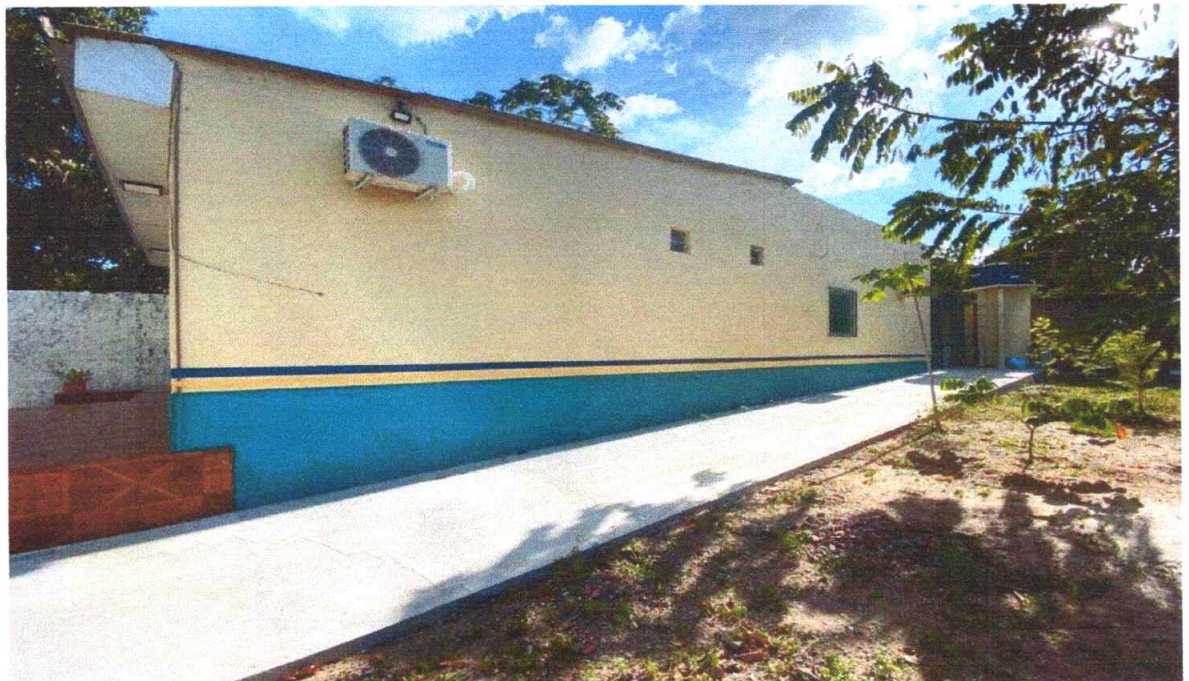
Figura 5 – Imagem da lateral do prédio.
