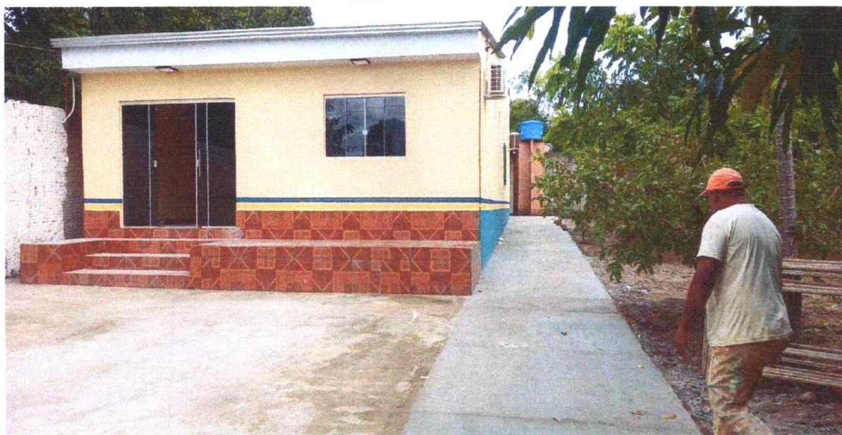
Figura 3 – Imagem frontal da porta de entrada do prédio.
